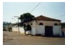
Armazém da ferrovia em Dumont, um pouco antes da chegada à plataforma de passageiros. Foto Ralph M. Giesbrecht em 25/08/2001
